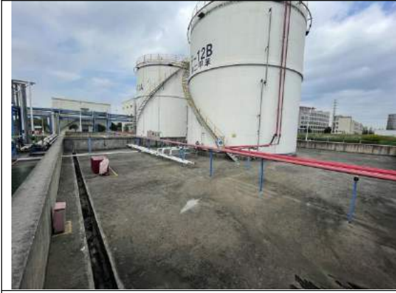
苯酚原料罐区
